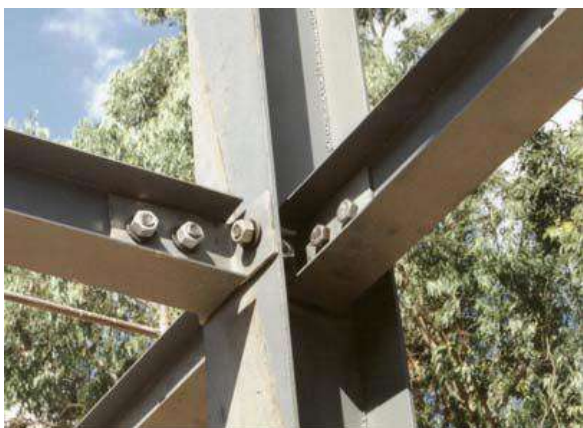
Figura 5: Fixação entre vigas e colunas
