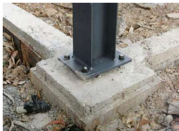
Figura 6: Fixação entre estruturas
