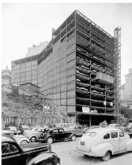
Figura 1: 1º Edifício em estrutura metálica no Brasil
