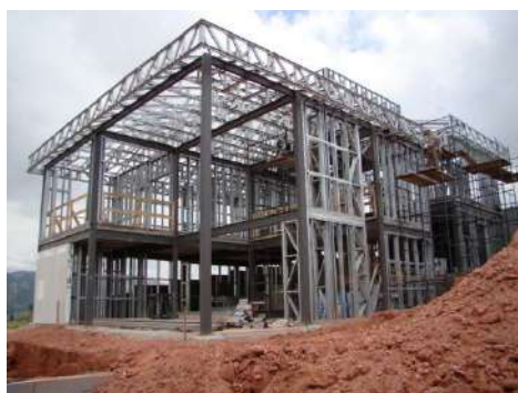
Figura 3: Estrutura Metálica com Stell Frame
